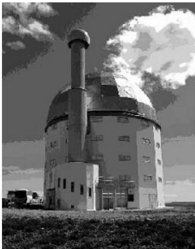
*Фиг. 3. Кулата на телескопа SALT. На преден план се вижда специалната юстировъчна кула за осигуряване на съгласуваната работа на сегментите на главното огледало.*
