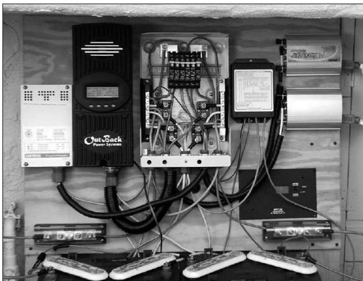
Фиг. 3. Ел. таблото за моята дуална ФВ система. Само половината от нещата са необходими за по-често използваната система от един панел. В дъното се вижда горната част на двата 12 V, 150 Ah акумулатора (един за всеки от панелите). Непосредствено над тях са 110 А бушони от клас Т (съгласно стандартите на САЩ, Канада и Мексико този клас бушони се включват при надвишаване на определена стойност на тока – бел. прев.). Вляво са двата зарядни контролера. Тъмният представлява зарядов контролер от тип, който следва максималната точка на мощност (MPPT), вж. описанието му в текста; той със сигурност е изключително добър за тази малка система. Горевдясно са два инвертора по 400 W. Под тях е един MPPT зарядов контролер, който засега не се използва. Наляво от инверторите е разположена системата за мониторинг, която понастоящем има възможността да измерва две напрежения и три различни тока. В центъра с отворен капак е кутията с прекъсвачи, показваща три прекъсвача на система, четири връзки, осигуряващи правените измервания (аз използвам едновременно само три), и за всеки от панелите, свързани и заземени шини, метални пластини, които позволяват разклоняващи се връзки. Заземените, отрицателните и положителните проводници са с различни цветове. Двата изходни кабела най-вдясно са връзката към домашните устройства, захранвани от системите. Тази специфична реализация на системата не изисква защитно устройство срещу авария в заземяването
