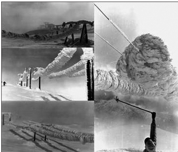
Фиг. 13. Заскрежаване на 20 \text{ kV} електропровод в планината Лонахорги, над гр. Вос, Норвегия – най-голямото досега измерено и документирано натоварване от обледяване – 305 \text{ kg/m} (фотограф Олав Вист; снимките са любезно предоставени от Свейн Фике)
