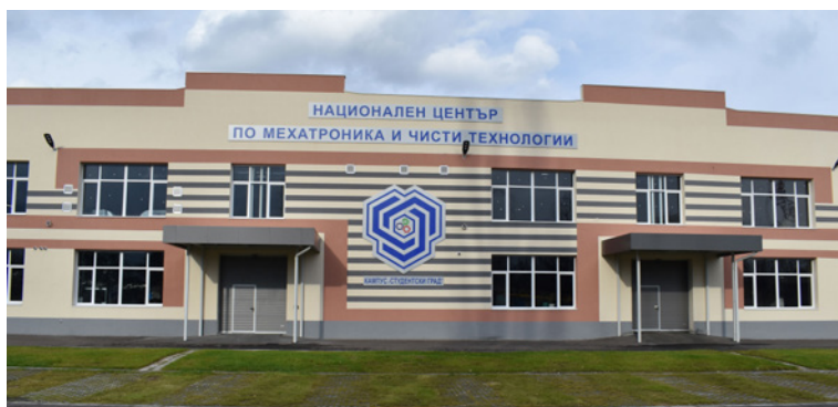
Реконструираният блок 8 в Техническия университет – София
