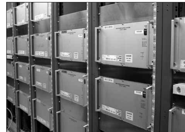
Фиг. 3 Високоволтовата система за захранване на адронния калориметър, изработена в ИЯИЯЕ, БАН в измерителния център на CMS
