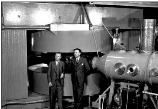
Фиг. 2. 60-инчовият циклотрон в Бъркли. На снимката е създателят на циклотрона Е. Лоурънс (E. Lawrence) и един от пионерите на ускорителната техника Куксей (Cooksey)
